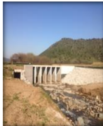
Bocatoma Canal Norte Unificado, barrera frontal.
