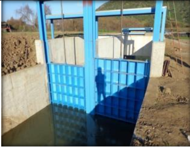
Avances en la instalación de marcos de compuertas.
